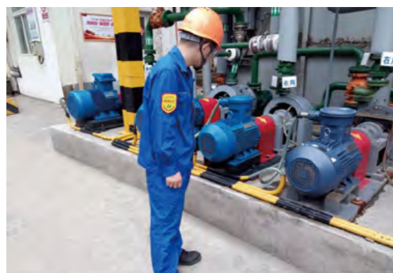
每日安全员现场巡查
